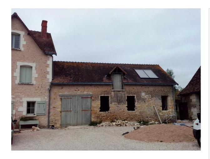
Chauffe-eau solaire de marque GASOKOL composé de 2 capteur TopSol pour une surface actie de 4,5 m² dans une maison en réhabilitation totale, couplé avec une chauf=dière à bois bûches.
