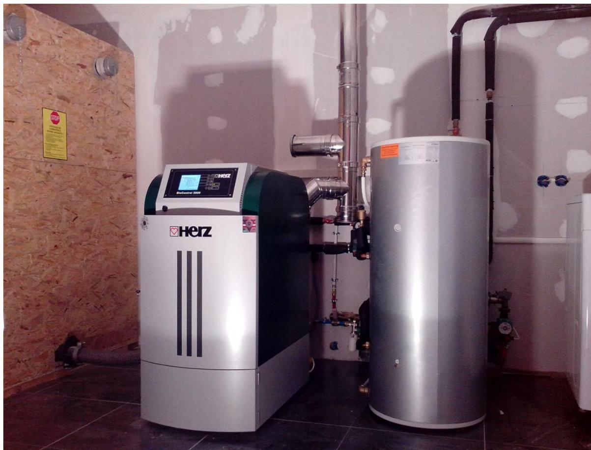
*Installation d'une chaudière à granulés HERZ 20 kW dans une maison en rénovation totale.*
